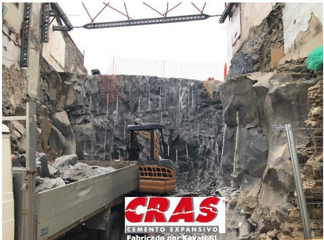
En las fotos pueden apreciarse las marcas de las perforaciones realizadas, una vez que las partes de la roca que quedan al exterior de las mismas se han desgajado del bloque. En este caso, la demolición se realizó tanto para el vaciado de una parte del solar como para la eliminación de un repié. El trabajo se llevó a cabo en el plazo previsto, y en menos de una semana se dejó el solar listo para continuar con la obra.
