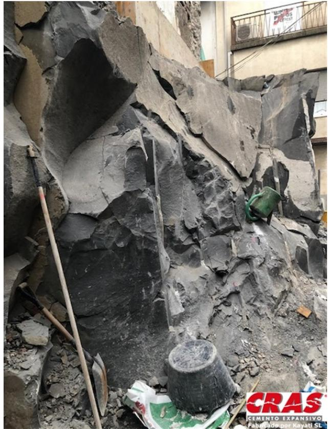
La perforación se lleva a cabo con una máquina perforadora Tamrock, con brocas de 38 mm a 51 mm. Es la parte más costosa del proyecto. Así como a la hora de oponer resistencia a la presión expansiva que desarrolla el CRAS cuando fragua la dureza de la roca no supone mayor problema, cuando se trata de realizar la perforación sí que este parámetro es fundamental, ya que, en ocasiones, hay que recurrir a cabezas perforadoras de alta dureza, en ocasiones refrigeradas.
