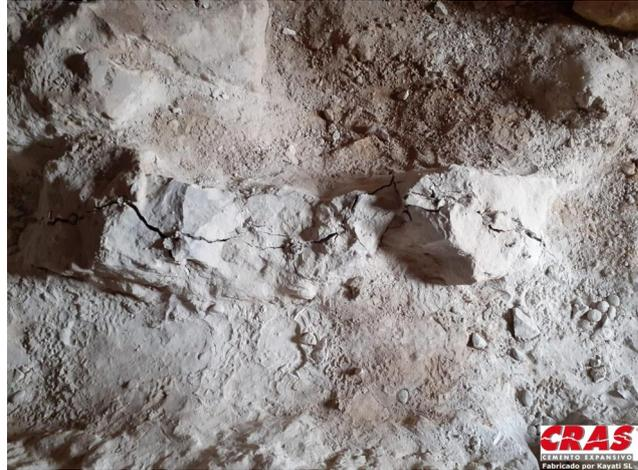
El trabajo que presentamos se ha realizado en el interior de una cueva. La falta de luz natural no supone ningún impedimento para que el proceso de demolición con el CRAS tenga lugar de manera natural siguiendo las pautas habituales en estos trabajos: perforación, preparación del mortero, vertido de éste en los agujeros preparados para esta función, espera durante las horas necesarias para que se produzca la reacción expansiva por hidratación, rotura y, finalmente, desescombro.
