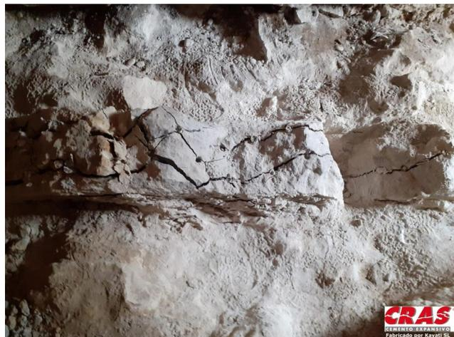
En el caso de demoliciones en el interior de cuevas o grutas, el CRAS permite realizar la demolición en lugares donde no puede utilizarse maquinaria pesada por imposibilidad de acceso de la misma a la zona a demoler.
