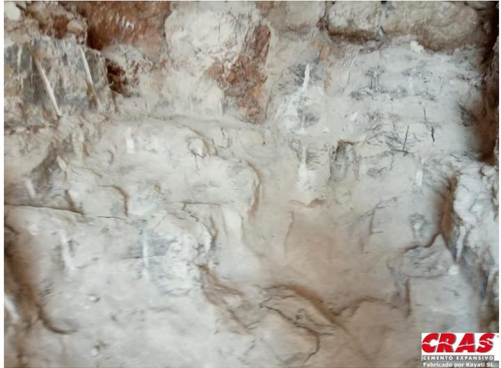
El CRAS utiliza la reacción expansiva de hidratación, un sistema para romper rocas utilizado ya en el Antiguo Egipto, que Kayati SL ha convertido en un proceso con sólida base científica y resultados visibles, durante treinta años, por todo el mundo. El CRAS es la esencia de la rotura controlada.
